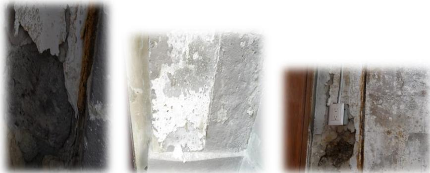
**Figura 2** Degradación de la cantera de los sillares y pérdida de material
